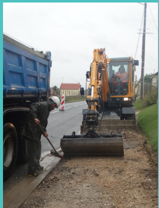
Travaux de refecton des trottoirs route de Montargis.
